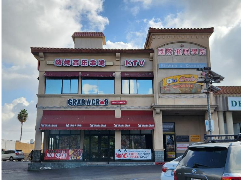
Figures 4.5.6-11. 2020 S Hacienda Blvd. (built 1970)
